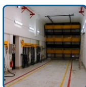
Tunnel n° 2 Cestas
